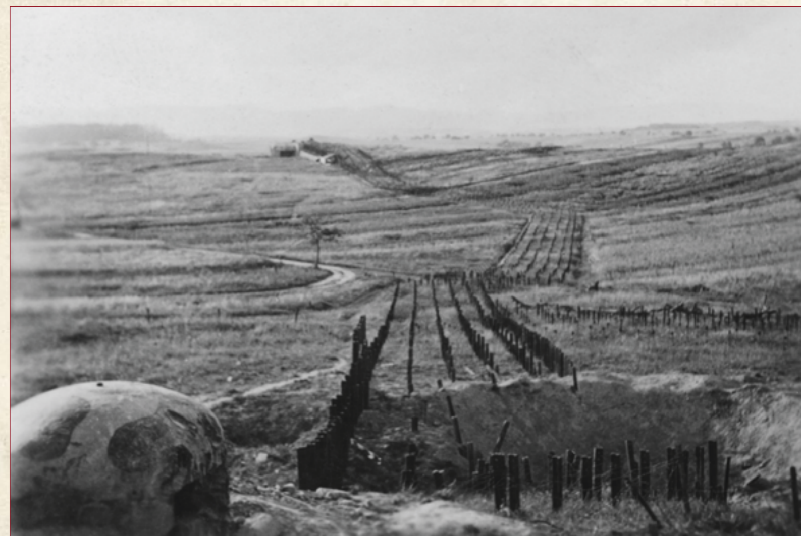
Cette photo de la casemate d'Aschbach Est vue depuis la casemate d'Oberroedern Nord dont on voit l'une des cloches au premier plan, nous donne une idée très représentative de l'obstacle constitué par le réseau de rails antichars dans les intervalles des ouvrages et des casemates. En contre-bas de la cloche, l'explosion d'une bombe allemande a creusé un énorme cratère dans le réseau mettant ainsi en évidence l'une des faiblesses de ce genre d'obstacle. On remarque le schéma du camouflage deux tons de la cloche GFM (collection Dominique Kemmel).
