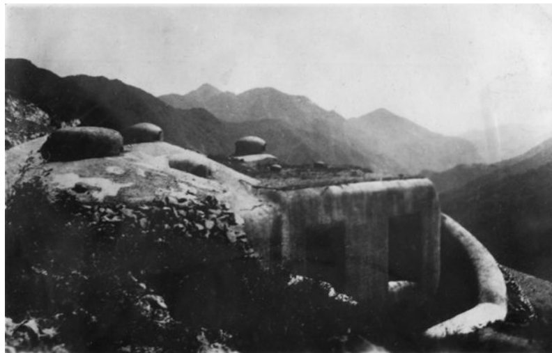
Ouvrage CORF Maginot de Flaut, Bloc n°3.
