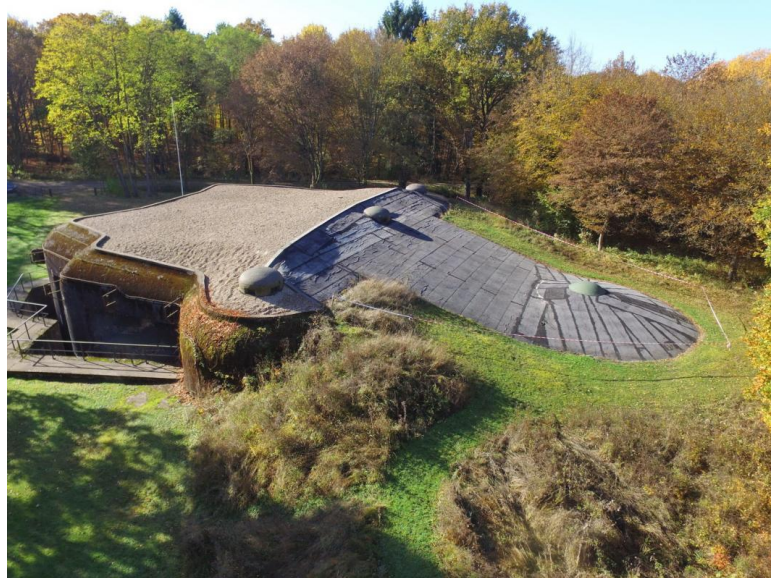
Figure 2 Vue aérienne de l'ouvrage du Bois Karre
