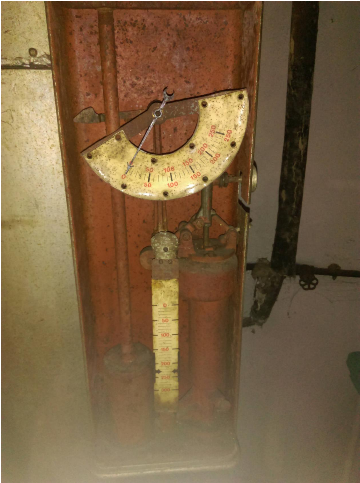
Figure 8 Régulateur de l'abri du bois de Cattenom, qui semble complet
